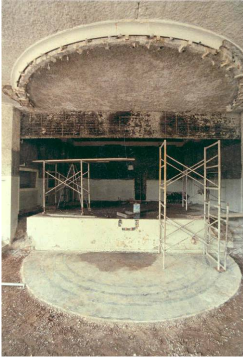
Εικ. 12 : Ο ημικυκλικός ραδιοθάλαμος-αμφιθέατρο της YENEΔ κατά τις εργασίες μετατροπής σε τηλεοπτικό studio, Θεσσαλονίκη Λ. Στρατού [Κεραμίδας, 1992 ]
