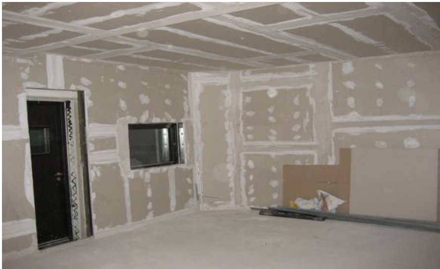
Εικ. 6: Εσωτερικός φλοιός γυψοσανίδων
