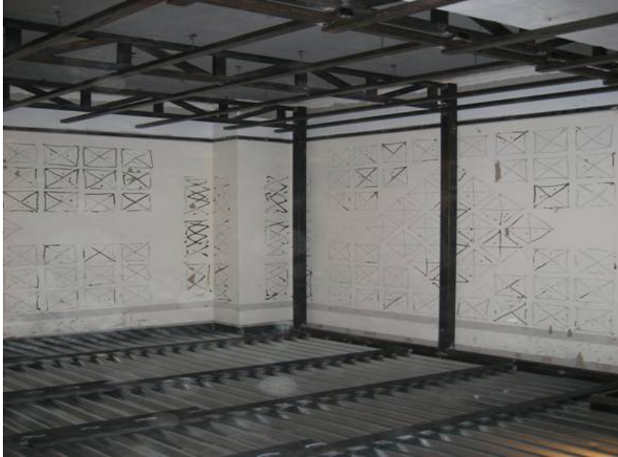
Εικ. 5: Μεταλλική κατασκευή δωματίου μέσα σε δωμάτιο
