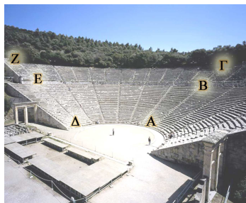
Εικ 3.1: Θέσεις ηχομετρήσεων και κατανομή ανάδυσης στο θέατρο Επιδαύρου
