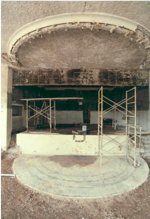
Εικ. 12 : Ο ημικυκλικός ραδιοθάλαμος-αμφιθέατρο της YENEΔ κατά τις εργασίες μετατροπής σε τηλεοπτικό studio, Θεσσαλονίκη Λ. Στρατού [Κεραμίδας, 1992 ]
