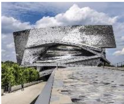
Σχήμα 3.7 Άποψη του κτιρίου [2]
